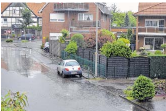
Die Belastungsgrenze erreicht: Die Schmutz- und Regenwasserkanäle am Diekamp sollen erneuert werden – zum Teil in offener Bauweise.
