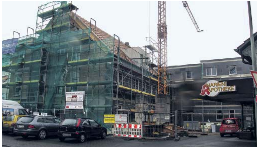
Noch eingerüstet: Das neue Wohn- und Geschäftshaus an der Ringstraße.
