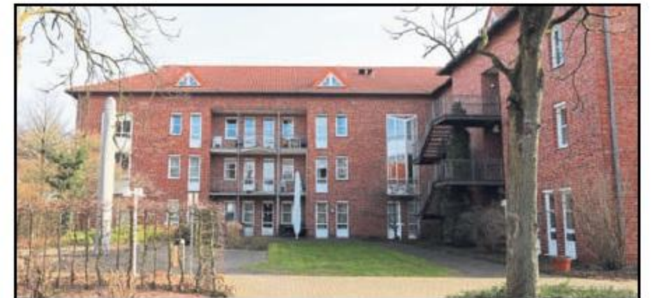
An dieser Stelle soll der dreigeschossige Neubau des Caritas-Hauses St. Anna entstehen.
