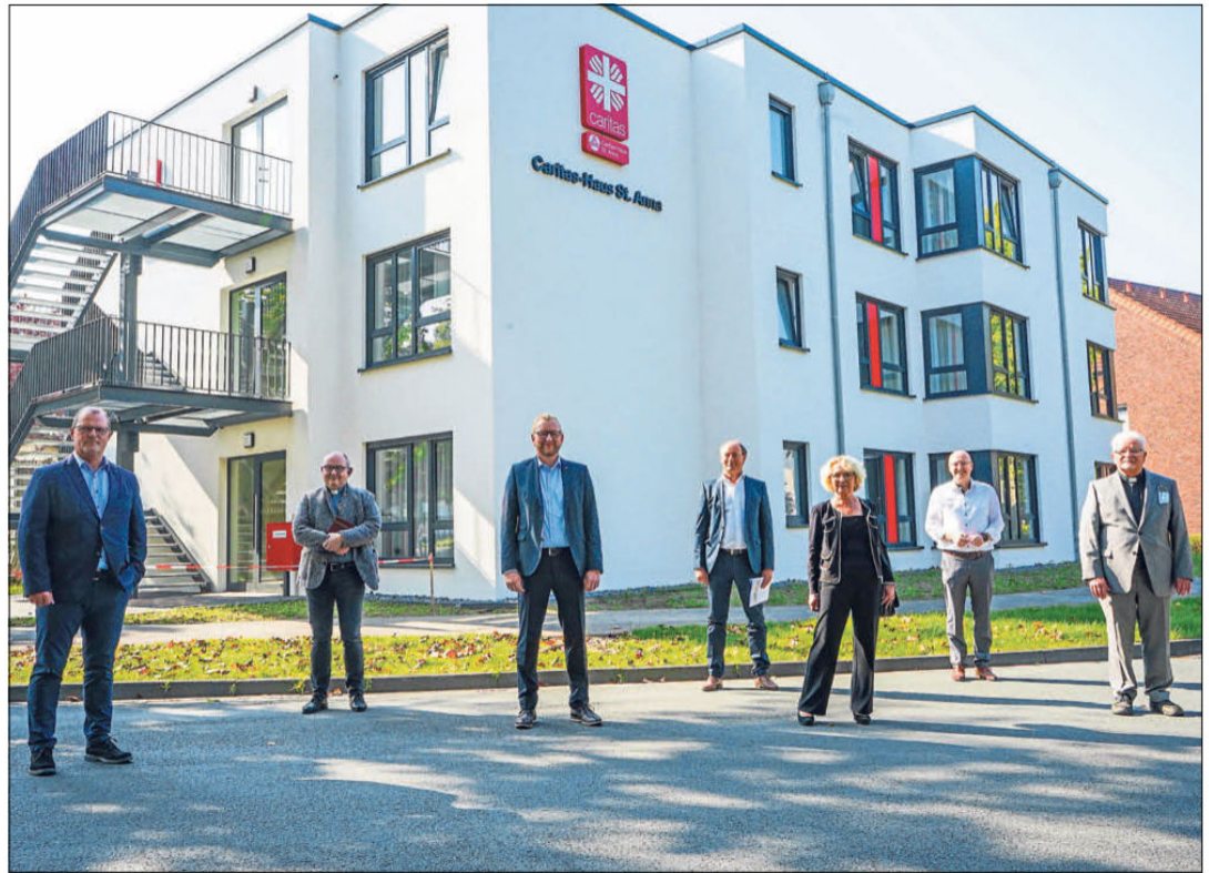
Weihten den Anbau des Caritashauses St. Anna ein: (v. l.) Einrichtungsleiter Jürgen Mertes, Pfarrer Karl-Josef Auris, Matthias Timmermann (Vorstand des Caritasverbands), Architekt Martin Brockmeyer, Brigitte
