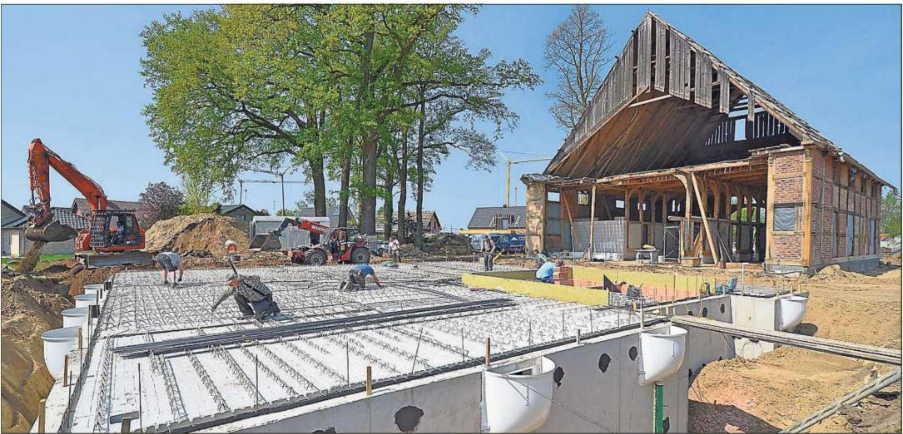
Südlich der alten Hofstelle Niggemeier entsteht ein Neubau, der später an den denkmalgeschützten Teil angebunden wird. Insgesamt werden 2,5 Millionen Euro in den Gebäudekomplex am Mastholter Ortsausgang investiert. Bilder: Vredenburg
