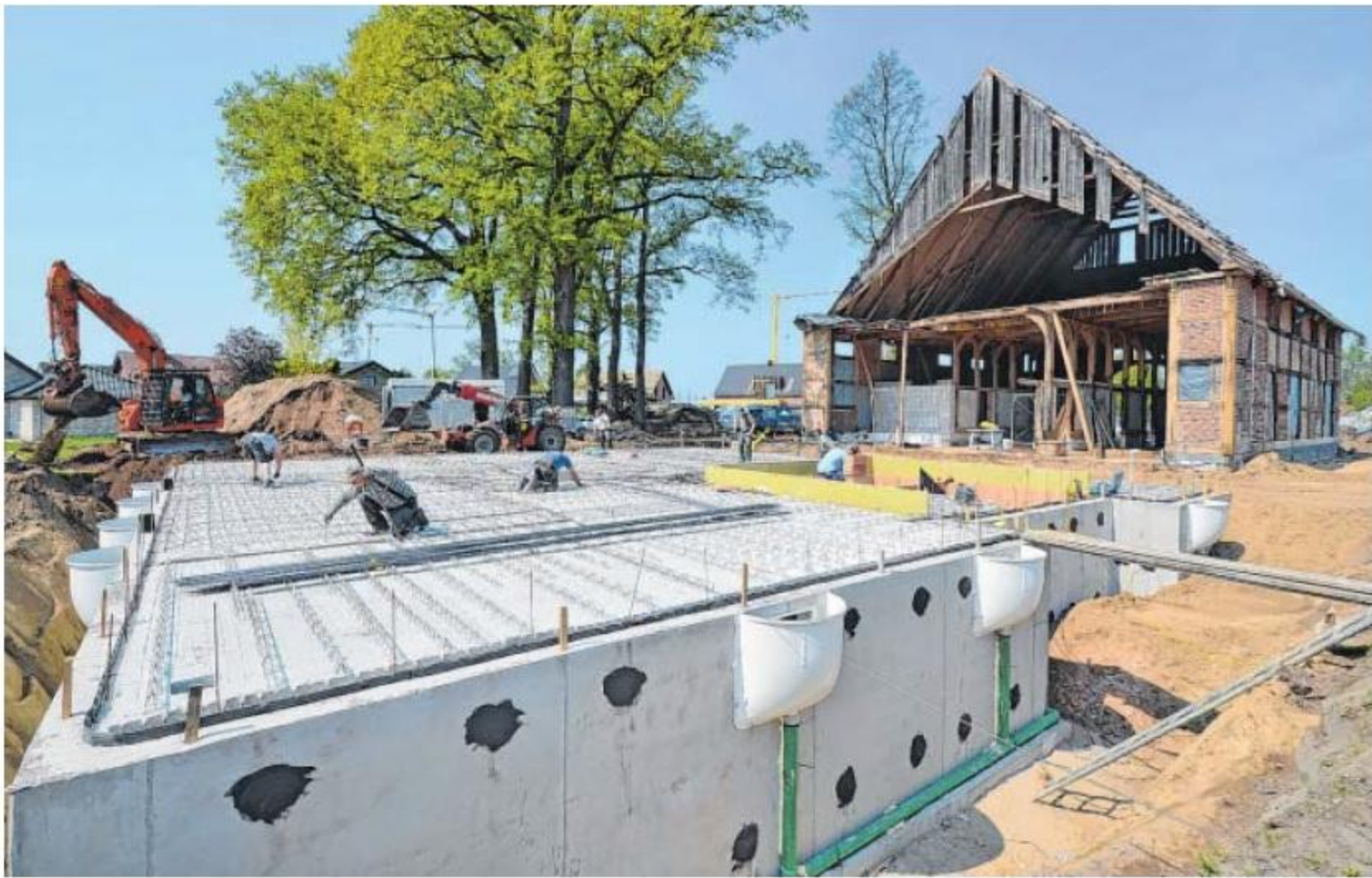
Alt trifft neu: Südlich der alten Hofstelle Niggemeier entsteht ein Neubau, der später an den denkmalgeschützten Teil (im Hintergrund) angebunden wird.
